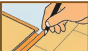
**3.** Разверните последнюю доску ряда так, чтобы ее гребень оказался напротив гребня предыдущей доски. Подгоните торец последней доски к стене. Отметьте карандашом линию отреза с отступом на 8-10 мм от края предпоследней доски для облегчения укладки.
